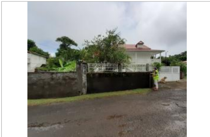
Mur de clôture
