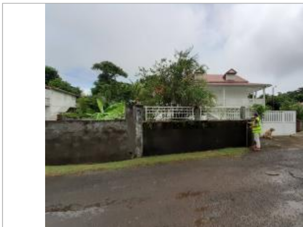
Mur de clôture
