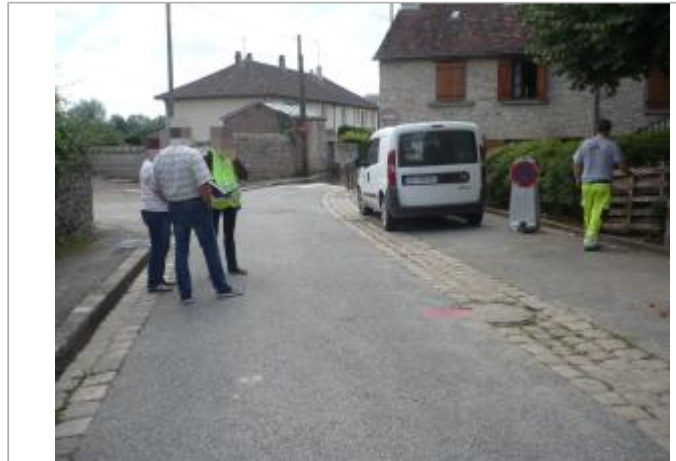
En face du 58 rue de l'église en remontant la rue à hauteur du regard d'égout
