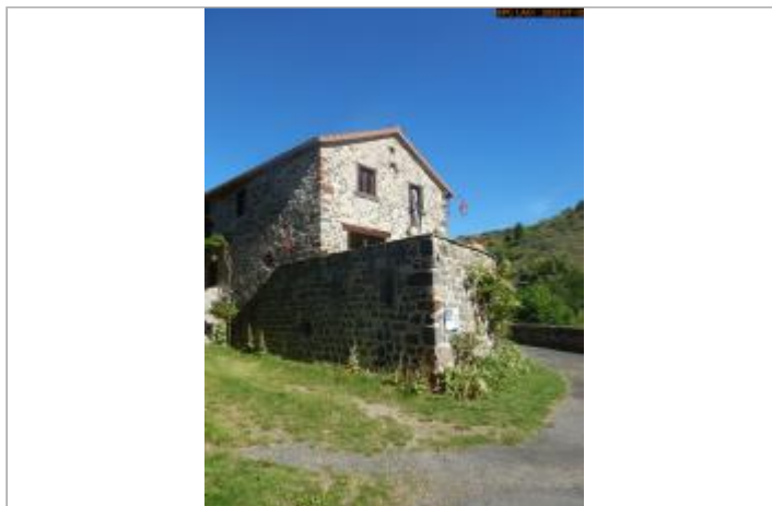
Vue du site éloignée
