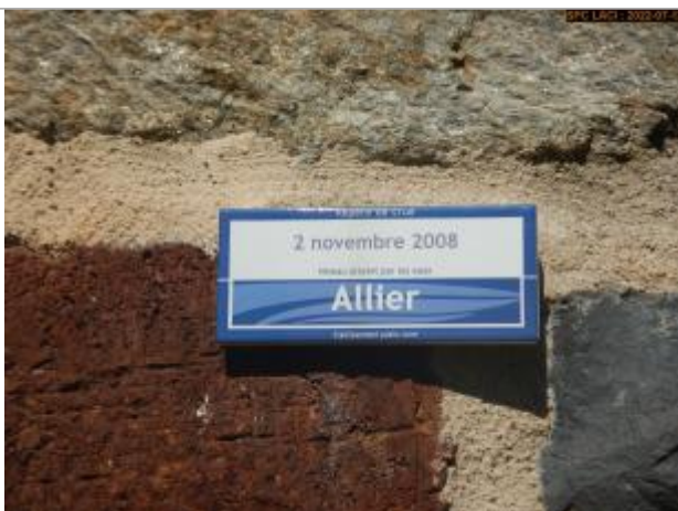
Vue du repère rapprochée
