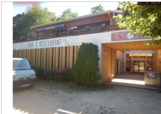
Vue du site éloignée
