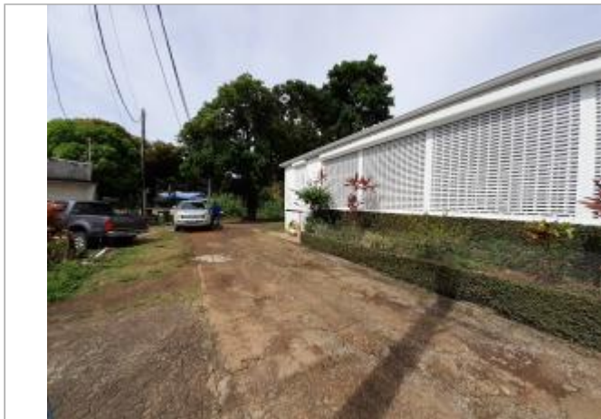
Façade extérieure en bois d'un sous-sol
