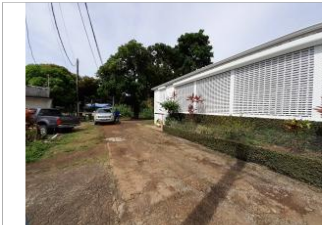
Façade extérieure en bois d'un sous-sol
