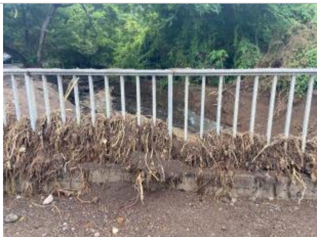
Dépôt de matières solides
