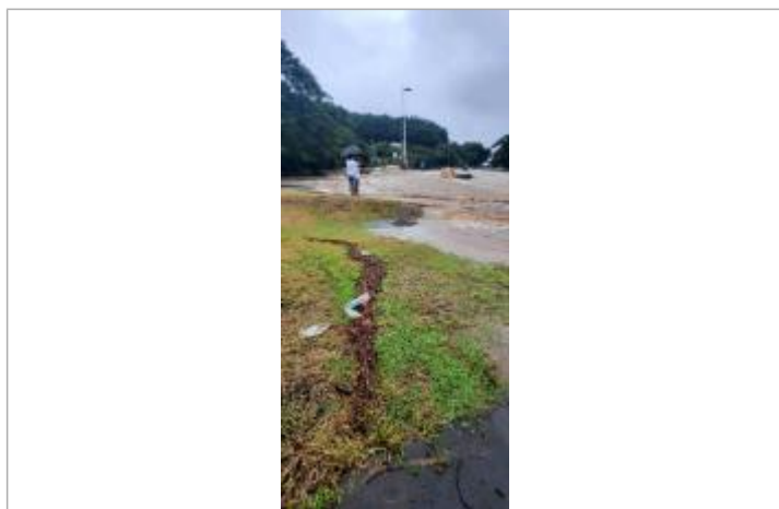
Dépôt de matières solides
