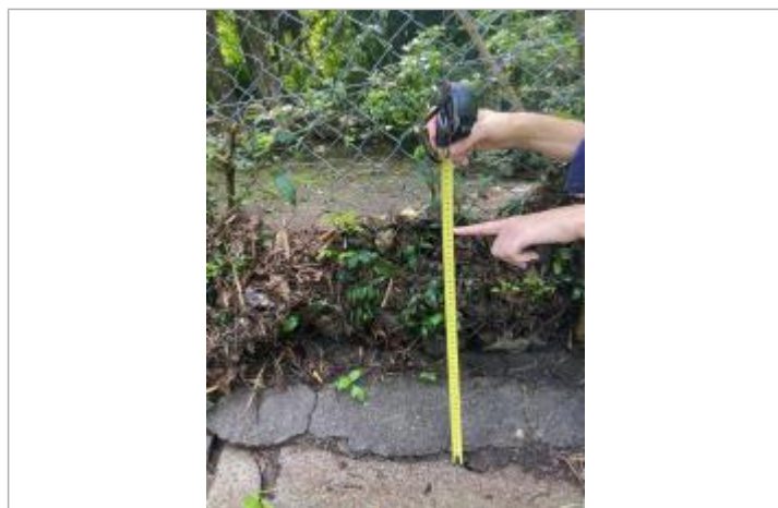
Dépôt de matières solides
