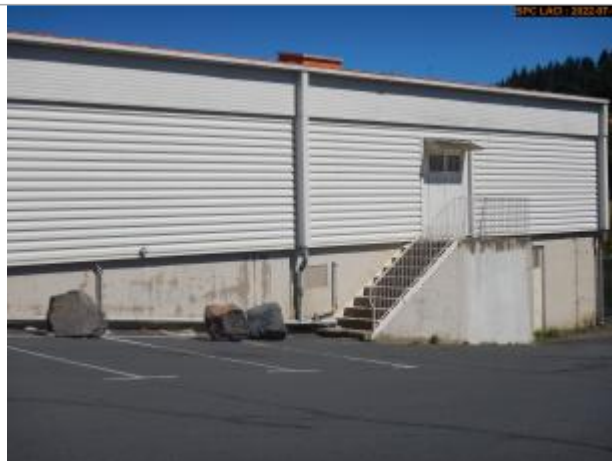
Vue du site éloignée
