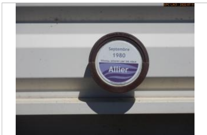
Vue du repère rapprochée
