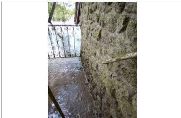
Vue d'ensemble du relevé sur le mur (Source : DDT 61).
