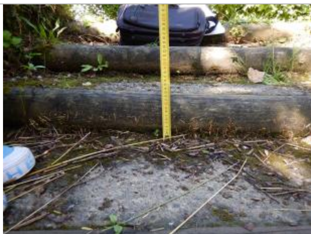
Vue rapprochée de la laisse de crue sur la deuxième marche (Source : DDT 61).
