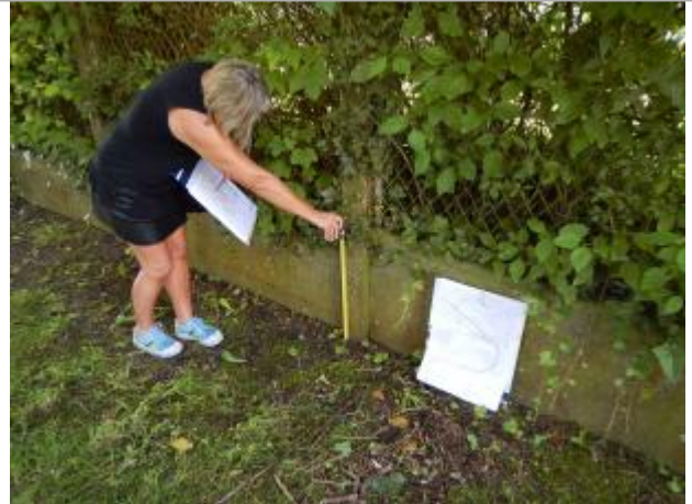
Vue d'ensemble du repère sur poteau en béton
