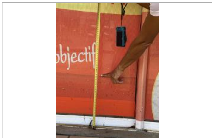
Dépôt de matières solides
