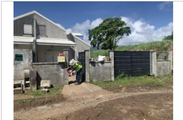
Mur de clôture
