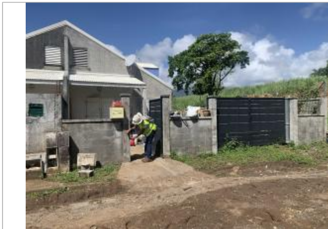
Mur de clôture
