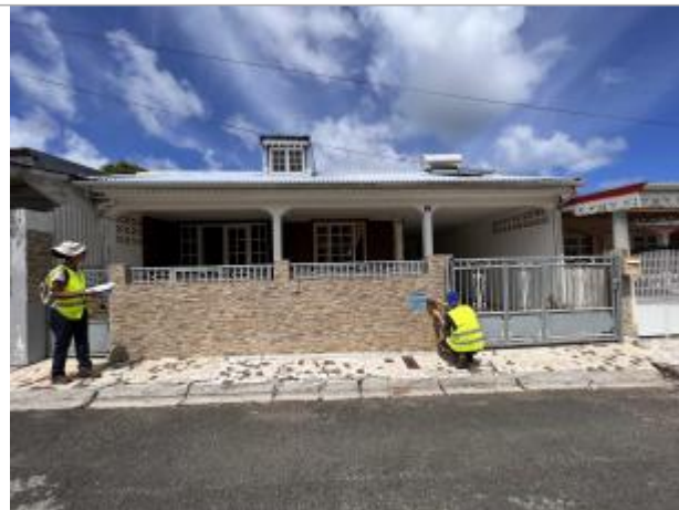
Mur de clôture
