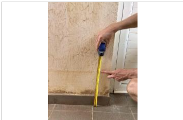
Dépôt de matières solides
