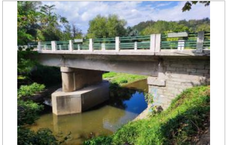
pont traversant la ville de Saint-Romain-en-Gier
