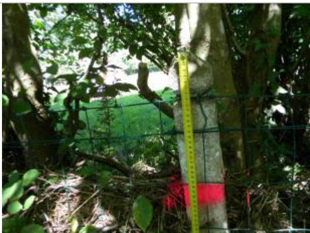
Vue rapprochée du coupe de bombe pour signaler la laisse de crue (Source : DTT 61)
