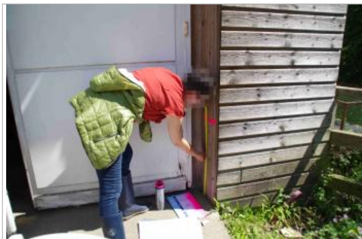
Vue rapprochée de la marque sur le mur de garage (Source : DDT 61)
