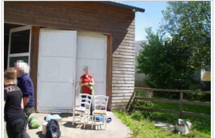
Vue complète de la porte de garage (Source : DDT 61)
