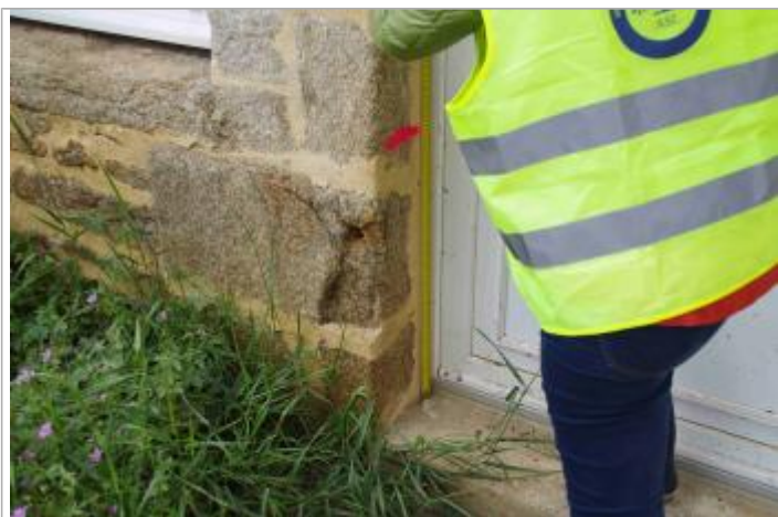
Vue rapprochée du repère sur une porte d'accès au domicile (Source : DDT 61)
