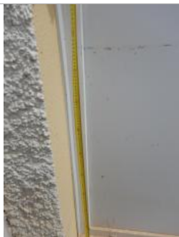
Prise de la mesure sur la porte du bâtiment (Source : DDT 61)
