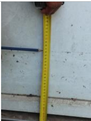
Marque prise depuis le seuil en béton de la porte de l'annexe de l'habitation (source DDT61)
