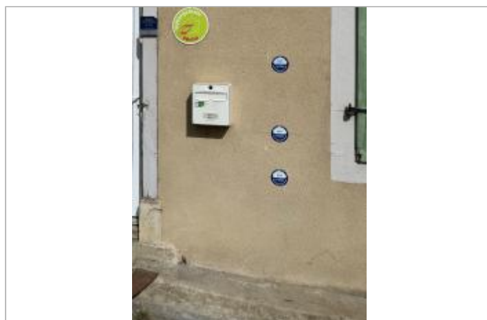
Des macarons reportant les PHE des crues des 10/01/2022, 25/01/2014 et 07/11/2011 ont été placés sur la façade du 6 rue du Salat.
