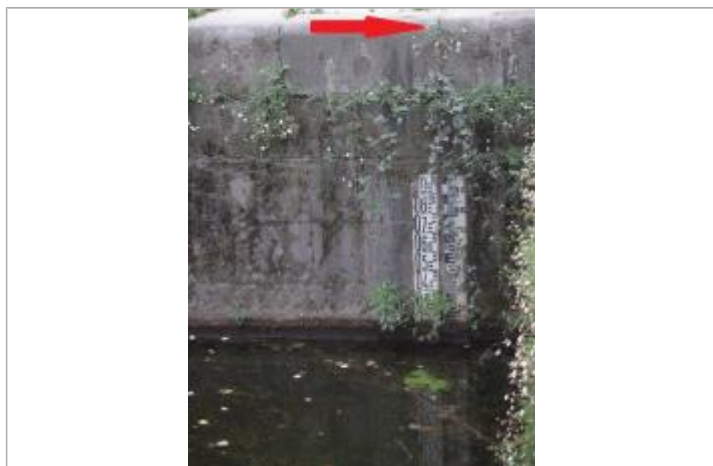
Ecluse du Mail à Rennes - échelle amont
