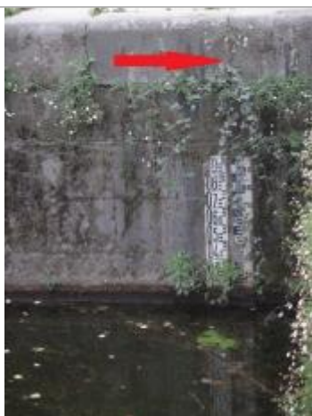
Ecluse du Mail à Rennes - échelle amont
