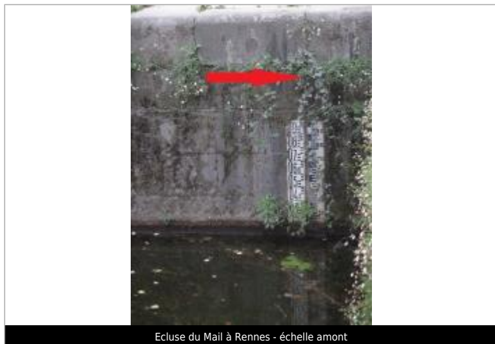
Ecluse du Mail à Rennes - échelle amont
