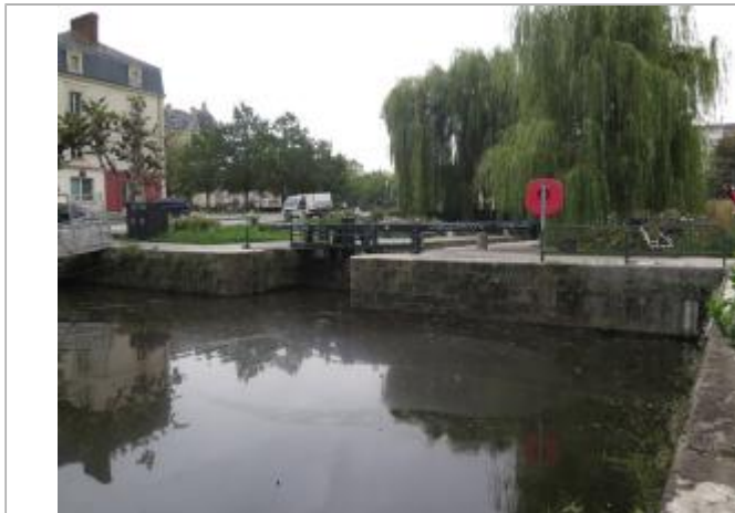
Ecluse du Mail à Rennes - échelle amont
