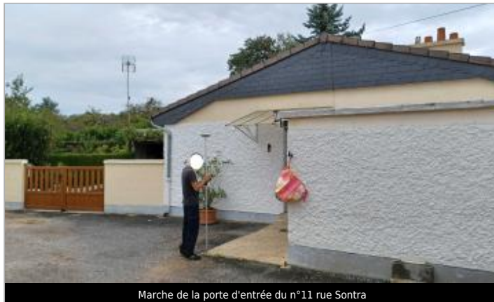
Marche de la porte d'entrée du n°11 rue Sontra
