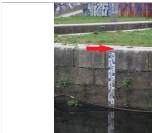
Ecluse St-Martin à Rennes - échelle amont
