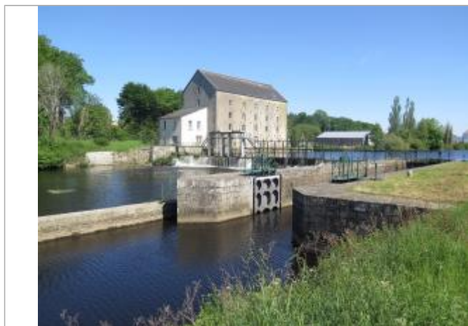
Aval de l'écluse de Signan - St Michel à Pontivy (échelle disparue)
