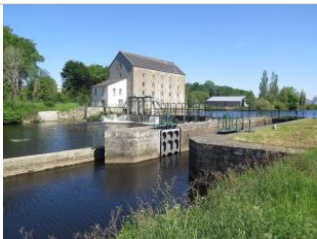
Aval de l'écluse de Signan - St Michel à Pontivy (échelle disparue)
