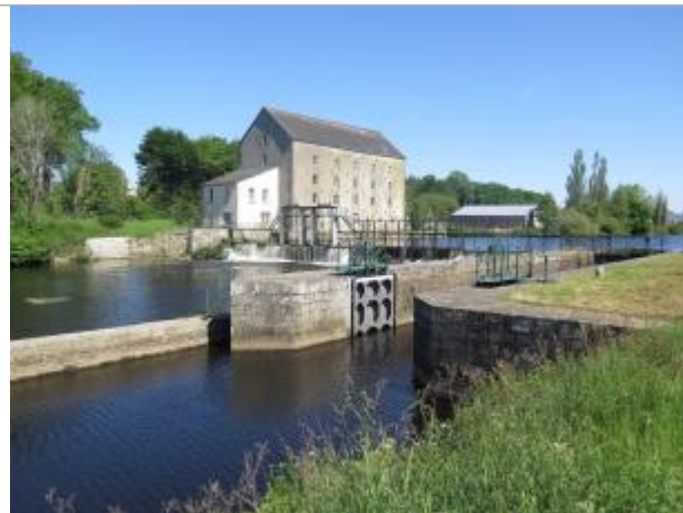
Aval de l'écluse de Signan - St Michel à Pontivy
