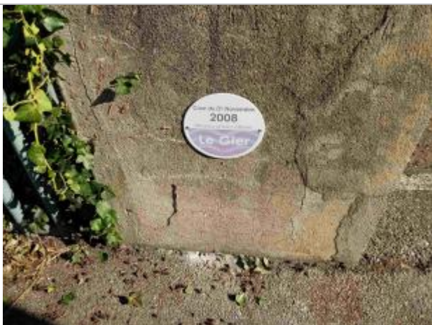
Repère installé en 2022
