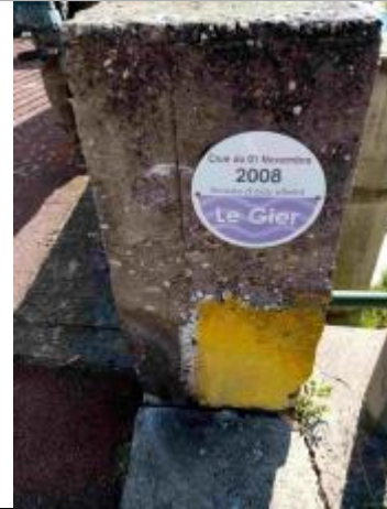
Repère posé en 2022
