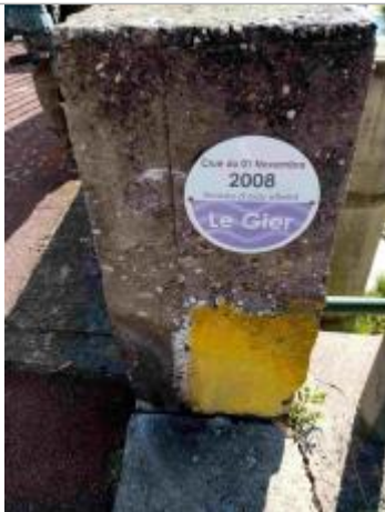
Repère installé en 2022
