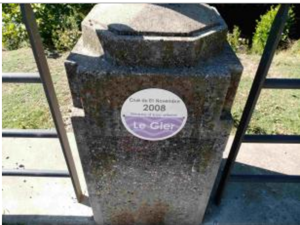
Repère installé en 2022
