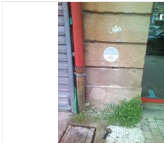
Repère installé en 2022
