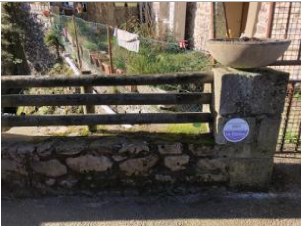
Repère installé en 2022
