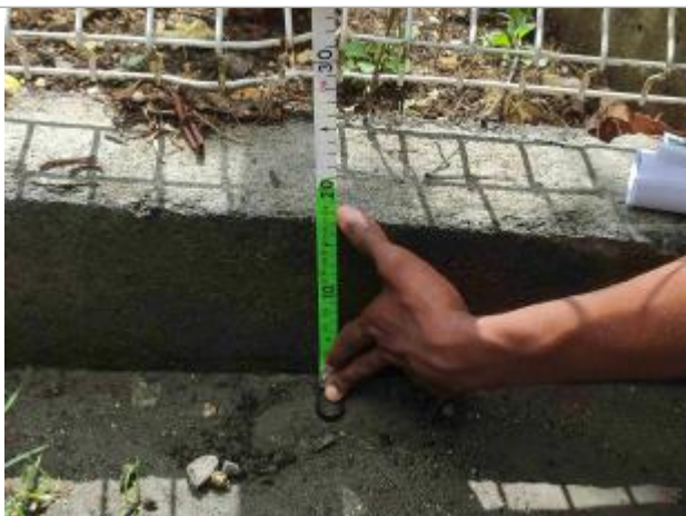
Dépôt de matières solides
