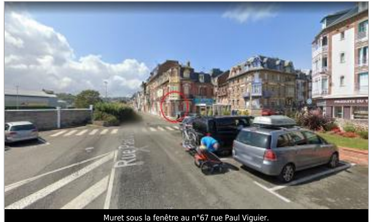
Muret sous la fenêtre au n°67 rue Paul Viguiier.
