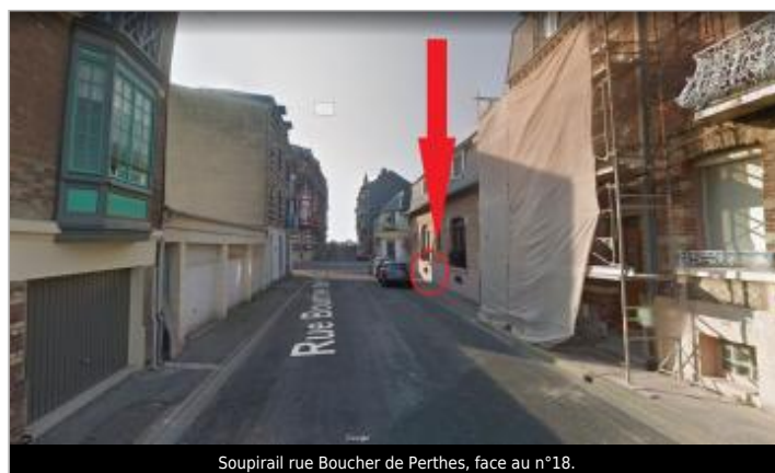
Soupirail rue Boucher de Perthes, face au n°18.
