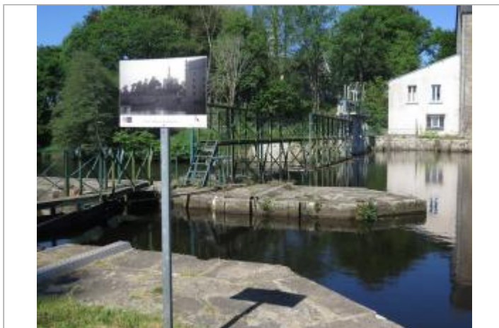
Amont de l'écluse de Signan - St Michel à Pontivy
