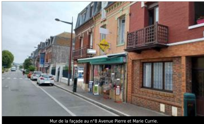
Mur de la façade au n°8 Avenue Pierre et Marie Currie.
