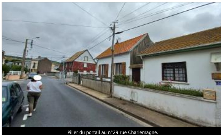
Pilier du portail au n°29 rue Charlemagne.
