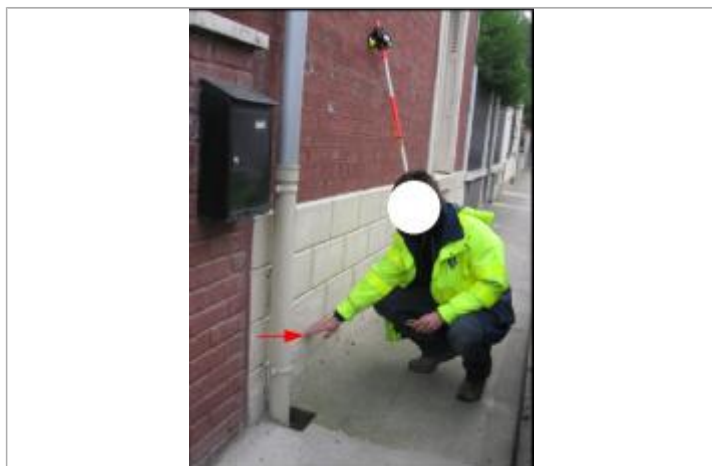
Laisse de crue sur la façade, en haut de la rangée de carrelage.
