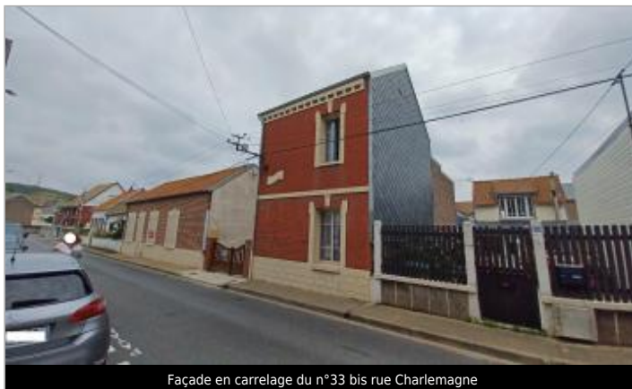
Façade en carrelage du n°33 bis rue Charlemagne
