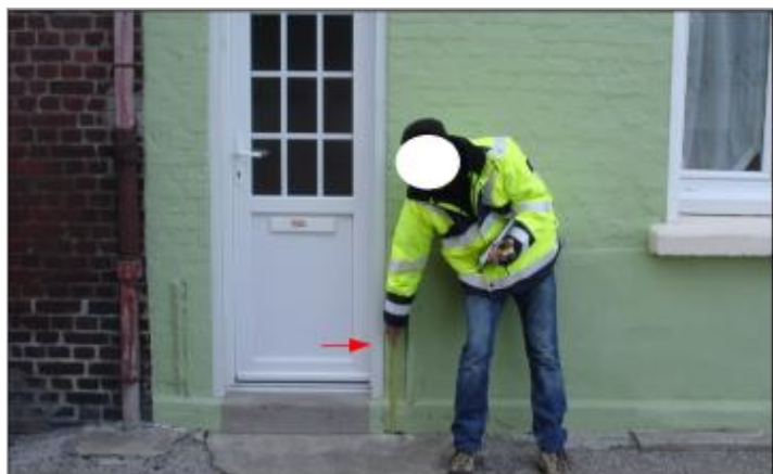
Laisse de crue sur la façade, à proximité de la porte d'entrée à 40 cm/sol.
