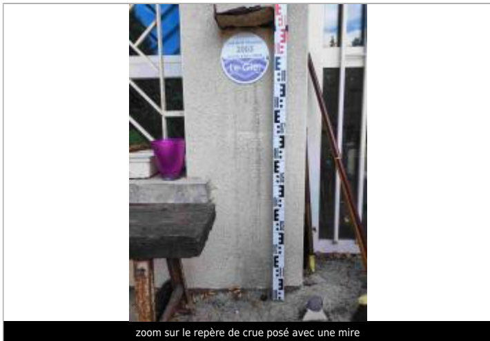
zoom sur le repère de crue posé avec une mire
